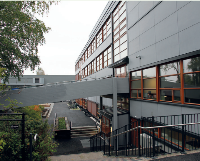
Det nye bygget har en kobberbrunaktig fasade, mens det rehabiliterte bygget har grå fasadeplater.
